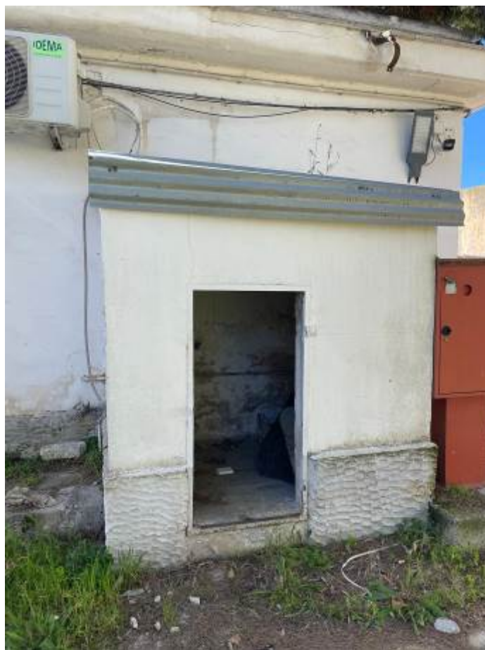
Figura 6 - Lato nord particolare ex locale calderina
