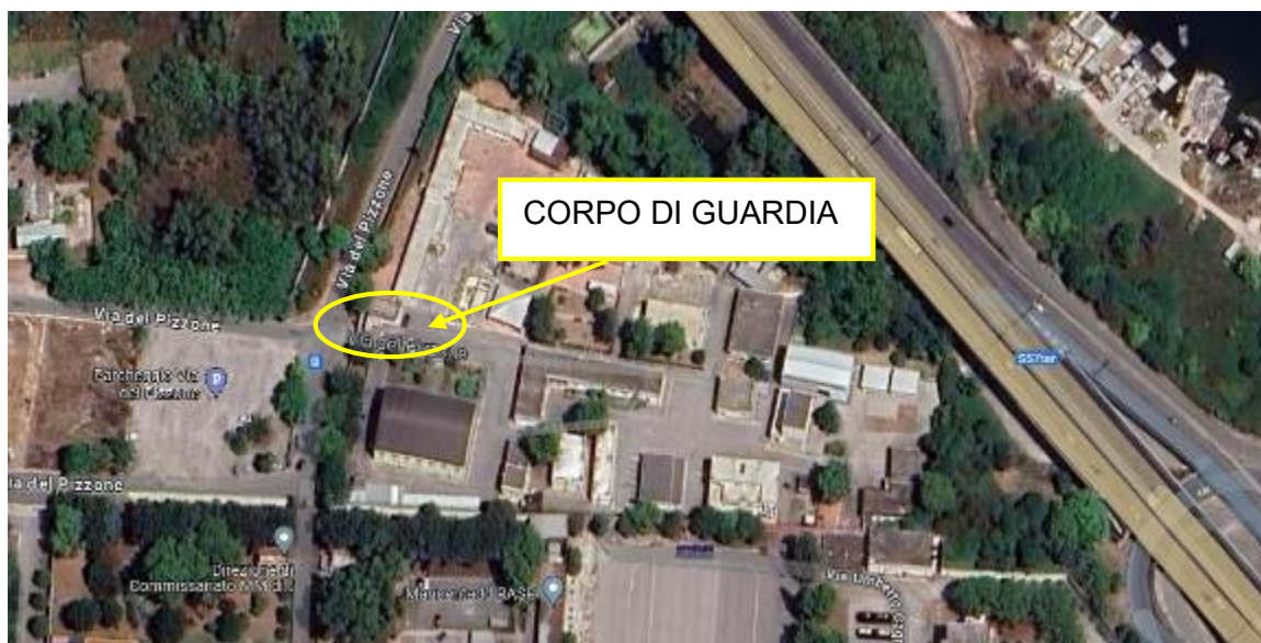
Figura 9 Particolare del sito
